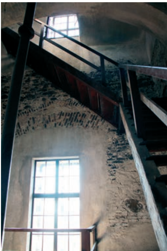
Vodárenská věž – interiér
