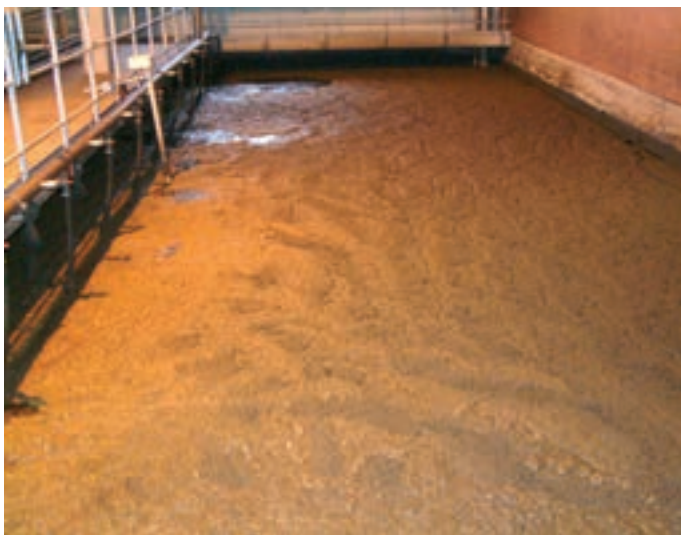
Obr. 4: Nitrifikační nádrž před intenzifikací
