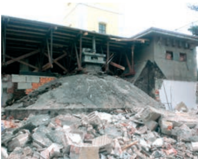
Demolice nepoužívané budovy s vodojemem
