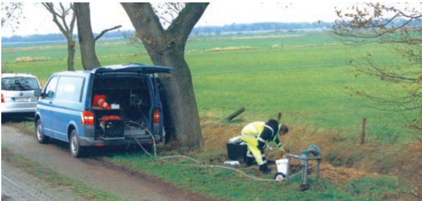
Obr. 1: Měření zasolení podzemní vody
