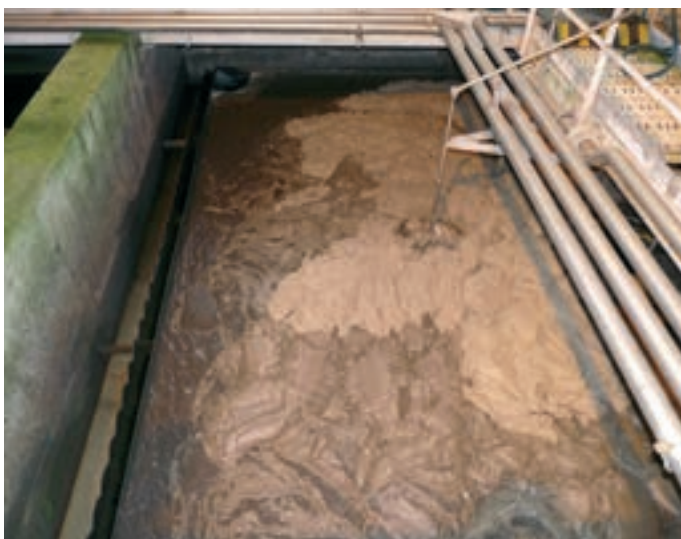
Obr. 2: Dosazovací nádrž před intenzifikací
