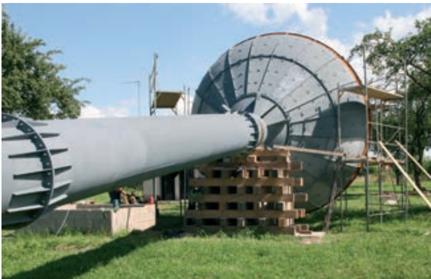
Oprava vodojemu v Jizerním Vtelně
