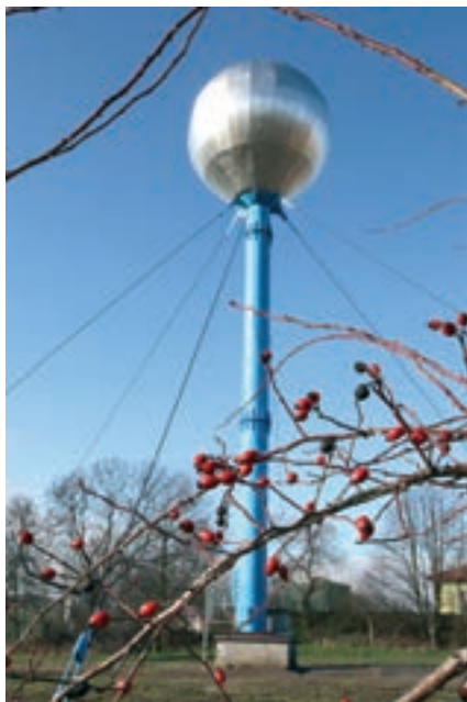
Zdětín – vodojem po opravě
