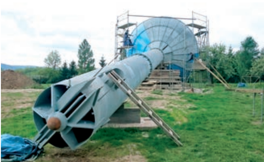
Oprava vodojemu v Loukovci
