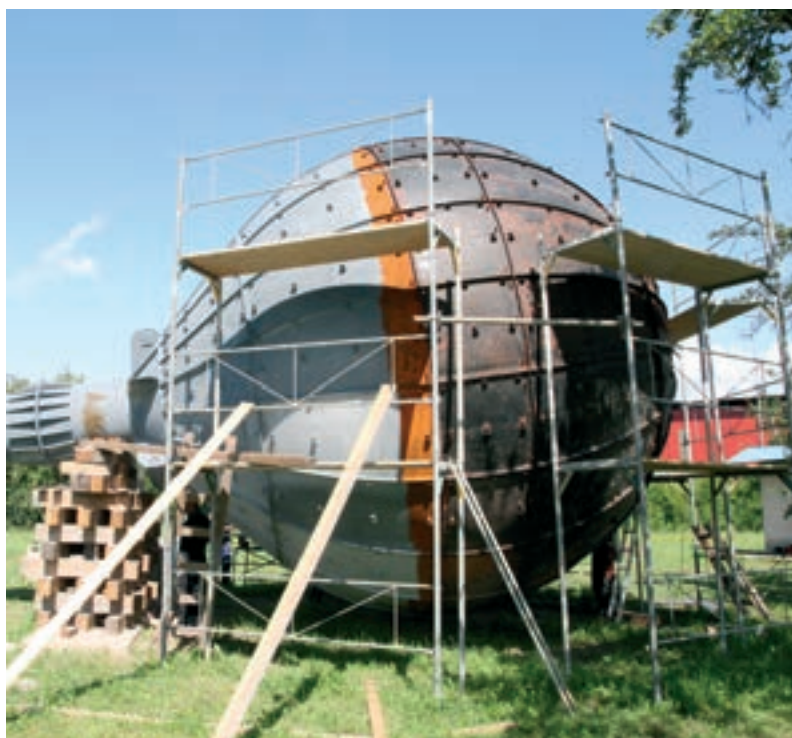
Oprava vodojemu typu Hydroglobus v Jizerním Vtelně
