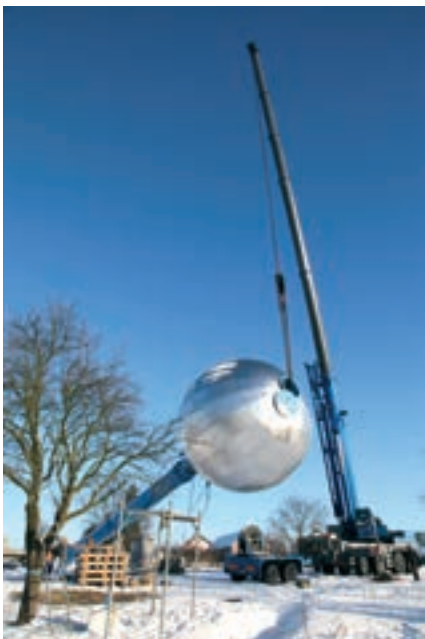
Vztyčení opraveného vodojemu
