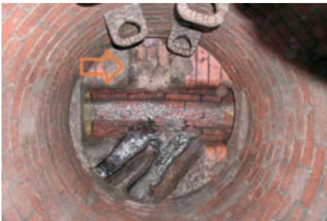
Obr. 2: Vstupní šachta s propojením na křižovatce ulic Zapova × Mošnova, Praha 5
