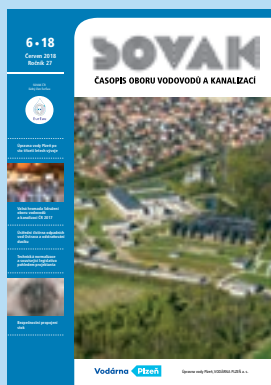
Letecký pohled na areál úpravní vody v Plzni
