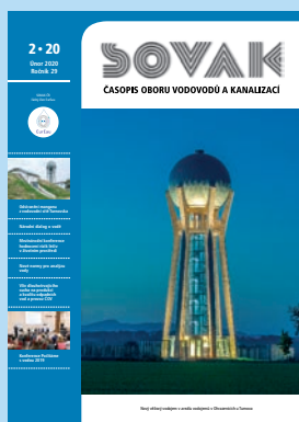
Nový věžový vodojem v areálu vodojemů v Ohrazenicích u Turnova
