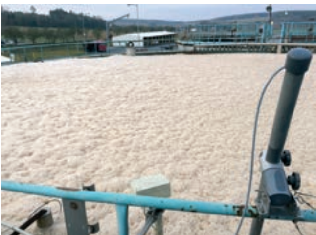
Obr. 4: Pění EPS struktur bez vlivu vláknitých bakterií
