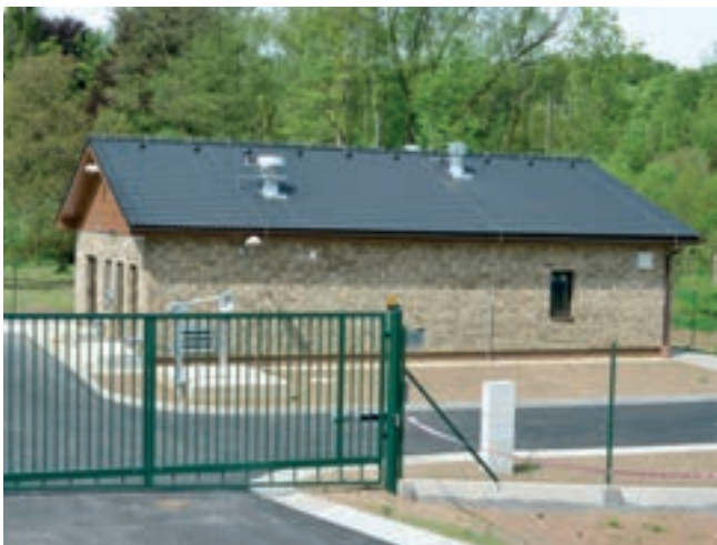
Nová ČOV v Rovensku pod Troskami – součást řešení odkanalizování celého města, počet EO 1 150
