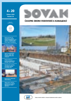
Stavba retenční nádrže A v Hranicích
