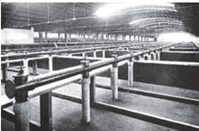
Hotové předfiltry naplněné pískem před napuštěním vodou
