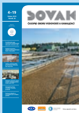
Čistírna odpadních vod Liberec
