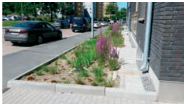
Obr. 3: Ukázka řízeného odtoku dešťové vody s infiltrací v systému SuDS. Zdroj: Sweco Environment – Stormwater Management, Sweden
