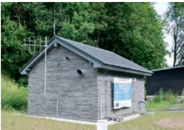
Čerpací stanice odpadních vod Dolní Štěpanice
