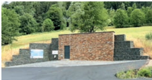
Vodojem Pod hradem
