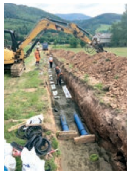
Souběh vodovodního přívaděče a výtlačného vodovodního řadu k vodojemu Kozinec
