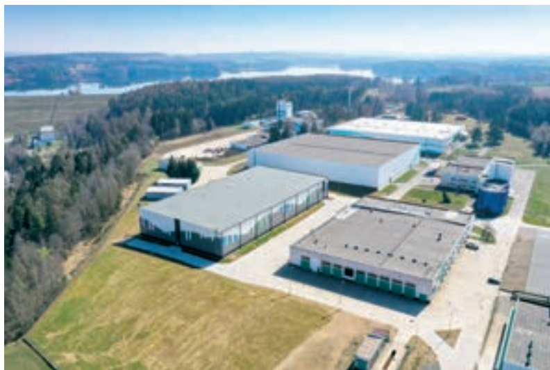
Nová hala filtrace GAU v areálu úpravny vody Želivka – současný stav
