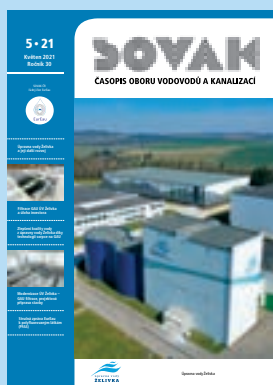
Úpravna vody Želivka
