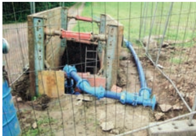
Obr. 3: Detail napojení provizorního obtoku u sanovaného úseku
