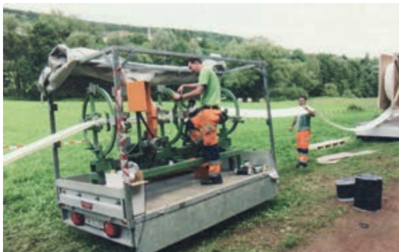
Obr. 2: Hadicová vložka se odvíjí z cívky a připravuje se k aplikaci
