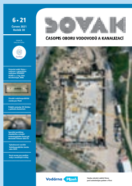
Stavba retenční nádrže Vinice pod Lochotínským parkem v Plzni
