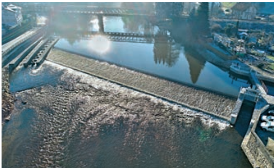
Jez Loket Dolní – rekonstrukce jezu
