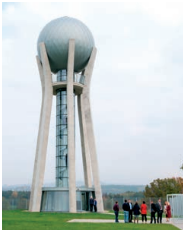
Věžový vodojem v Ohrazenicích v den slavnostního otevření. Zdroj: Archiv projektu, 2019
