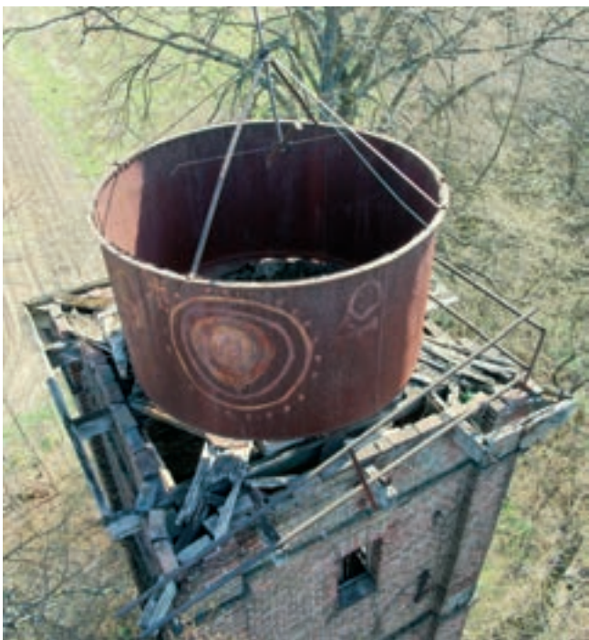
Pardubice-Dražkovice, detailní záběr nepřístupné střechy a nádrže vodojemu. Zdroj: Archiv projektu, 2019
