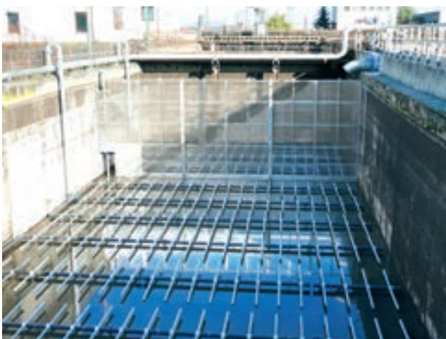
Linka s osadenými aeračnými elementami, namontovaná deliaca priečka denitrifikácie
