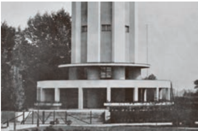
Výřez z dobového snímku poděbradského věžového vodojemu a ochoz osázený květinami. Zdroj: A. Hráský, F. Jenč, 15 let práce HaJ
