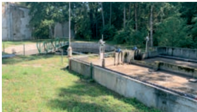
Obr. 7: Čistírna odpadních vod v Thomayerově nemocnici
