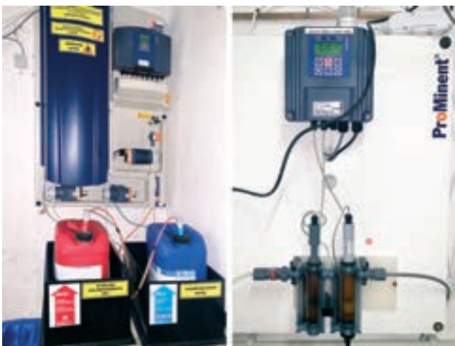
Obr. 9: Hygienické zabezpečení teplé vody
