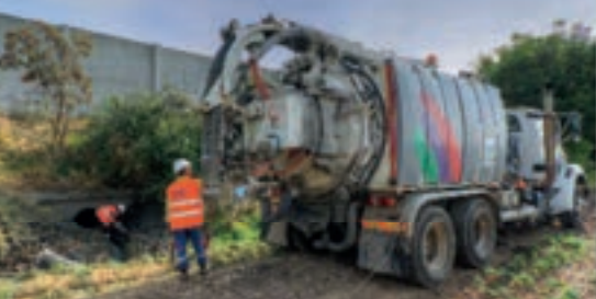
Čištění kanalizačních sběračů kombinovanými vozy
