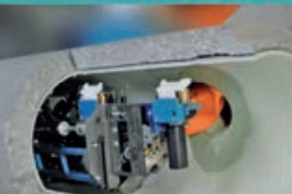
Oprava zaústění kanalizační přípojky injektáží robotem KA-TE
