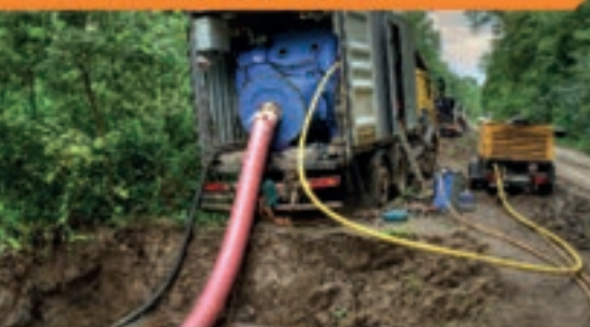
Instalace vystýlky KAWEX do vodovodního potrubí
