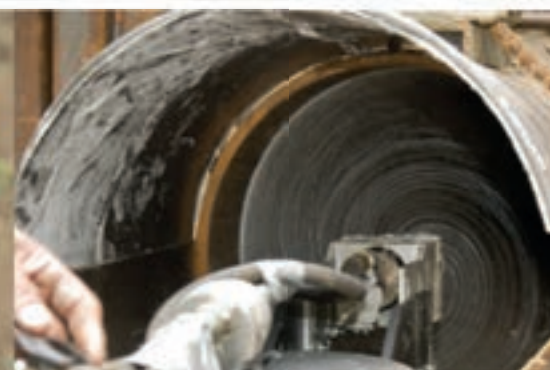
Sanace vodovodního potrubí nástřikem epoxidem
