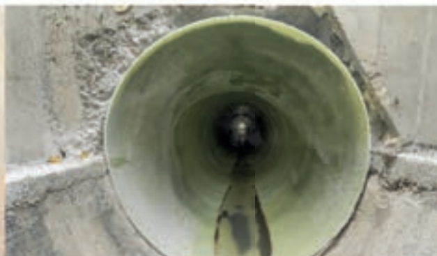
Kanalizační potrubí po instalaci vystýlky KAWO UV
