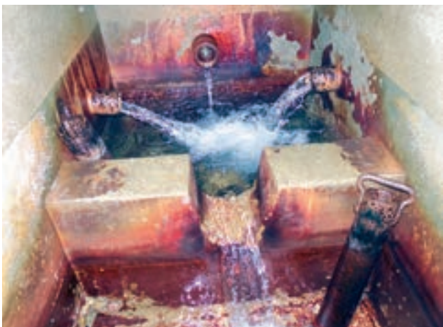
Pramenní jímka před rekonstrukcí
