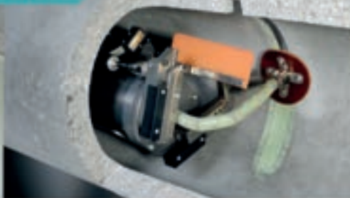
Lokální oprava potrubí injektáží robotem KA-TE
