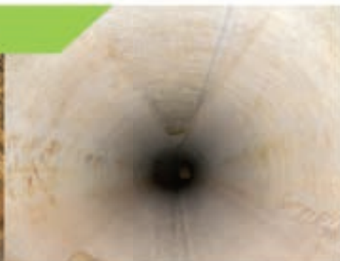
Kanalizační potrubí po instalaci vystýlky KAWO
