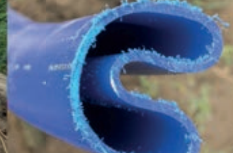
Sanace potrubí technologií P SYSTÉM z HDPE 100 RC
