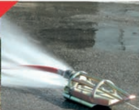
Čištění kanalizačních sběračů vysokotlakým vodním paprskem
