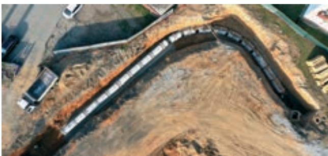
Obr. 6: Oblouk kanalizace z ptací perspektivy
