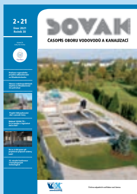
Čistírna odpadních vod Bakov nad Jizerou
