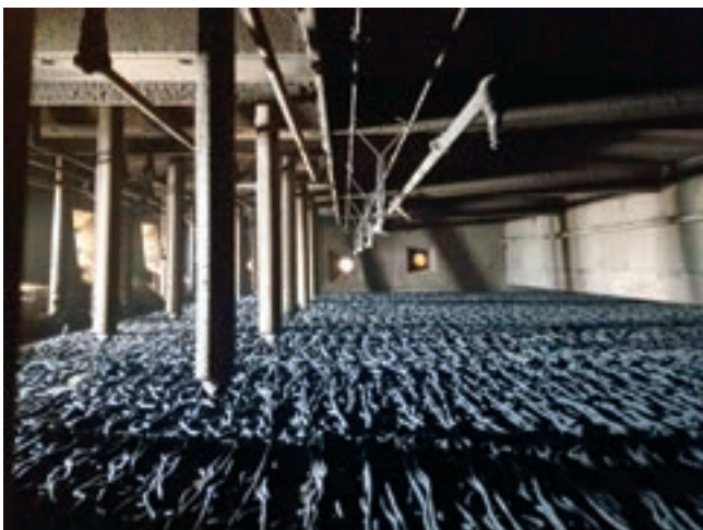
Obr. 1: Sušárna BIOCO ČOV Štětín Pomořany – distribuce kalů na pás tryskami (první zóna sušení)
