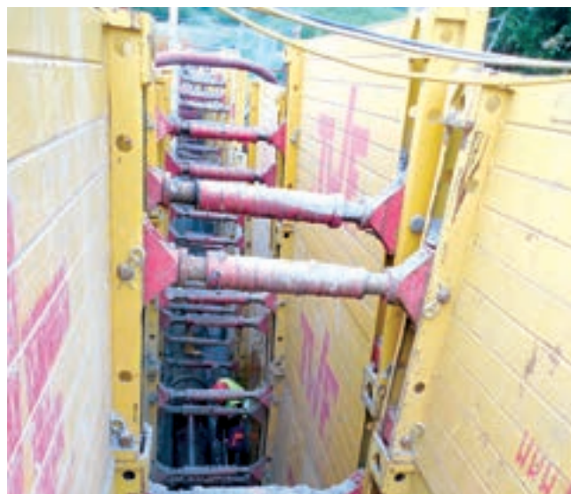
Pokládka potrubí KT 500 mm v hloubce 5 m
