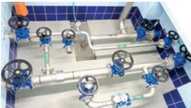
Vystrojení armaturní komory, realizace našimi zaměstnanci
