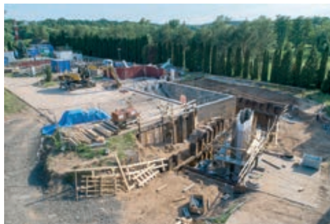
Výstavba nové čerpací stanice
