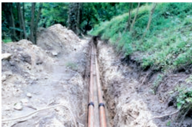
Pokládka zdvojeného výtliku odpadních vod HDPE 100, d 180 mm s ochranným pláštěm
