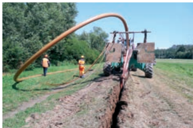
Pluhování PE potrubí s ochranným pláštěm
