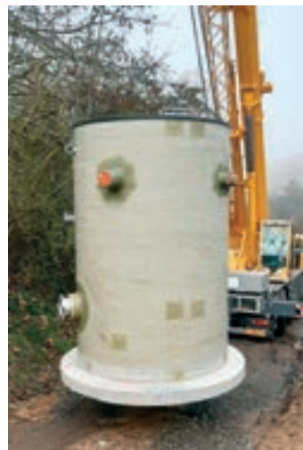
Obrázek vpravo: Montáž čerpací stanice se separací
