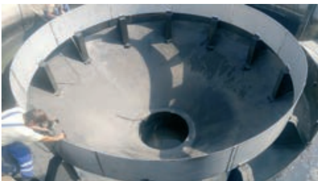
Obr. 5: Pohled na vypuštěný rozdělovací objekt [1]
