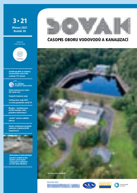
Úpravna vody Meziboří
