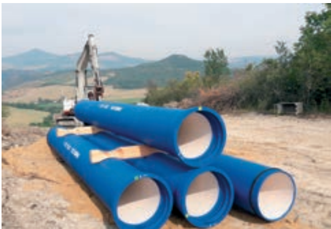
VDJ Michalovice–AŠ Libochovany – rekonstrukce přivaděče
