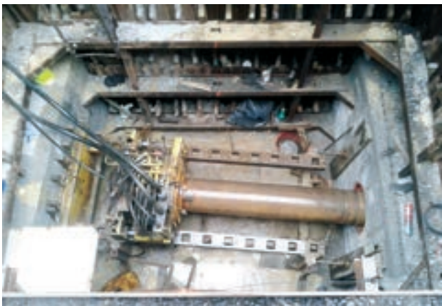
Obr. 3: Zatlačení ocelové výpažnice
