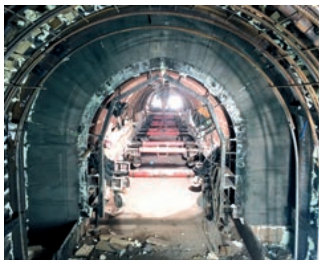
Obr. 3: Posuvné bednění na stoce v ulici Dvorského
