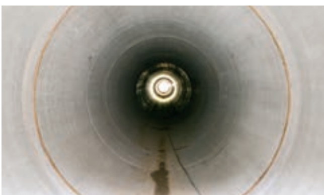
Obr. 12: Brno – VOV, pohled do protlaku DN 1 800 mm pod dálnicí D1
