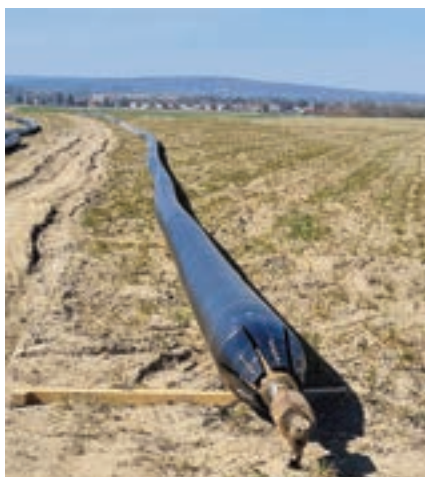
Připravený svařenec s vlečným kuzelem
