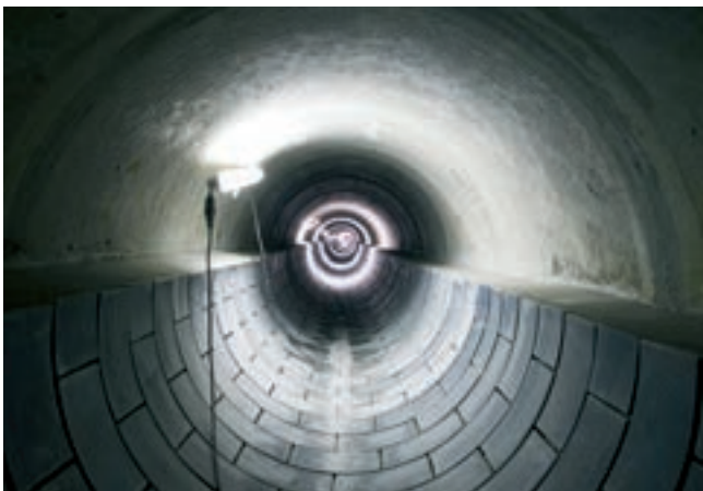
Obr. 11: Protlak s čedičovou kynetou, pohled do nejdelšího úseku o délce 80 bm
