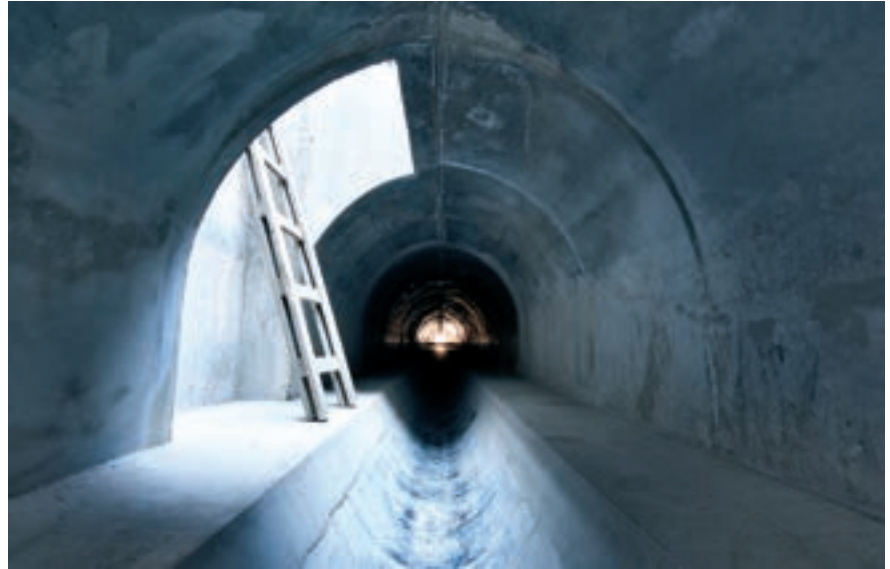
Obr. 4: Staňkova – monolitické ostění DN 1 000/1 600 mm před betonáží kynety z čediče a kompletně dokončená stoka v ulici Dvorského s čedičovým žlabem
