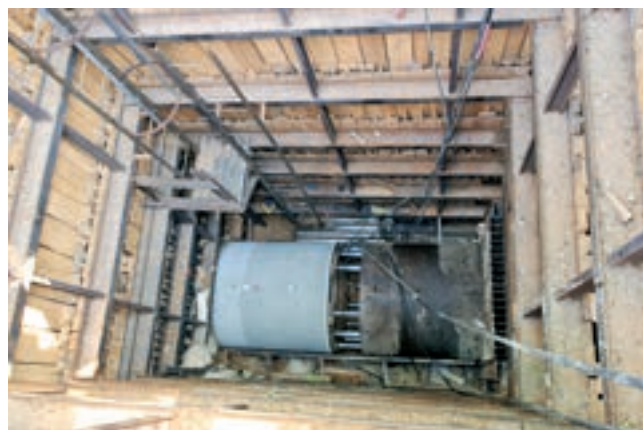
Obr. 9: Pohled do startovací šachty na protlačovací stanici typ Žab 3-09 vzor Ingstav
