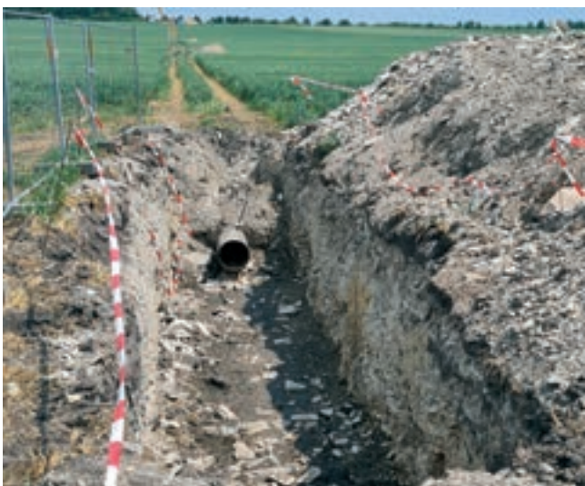
Příprava původního potrubí pro zatažení nového plastového
