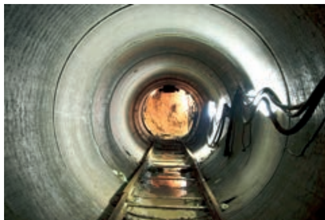
Obr. 10: Pohled do čela protlaku DN 1 600 mm, ideální geologické podmínky pro ražbu
