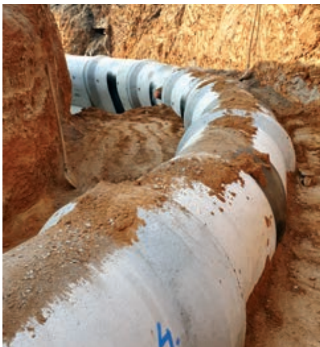
Obr. 5: Detail trasy obloukových betonových trub
