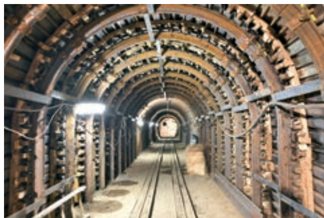
Obr. 1: Pohled do štoly v ulici Dvorského – podkovovitý profil DN 2 650/2 700 mm
