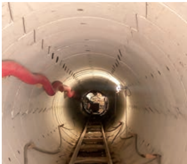
Obr. 16: Detailní pohled na segmentové ostění štítované štoly
