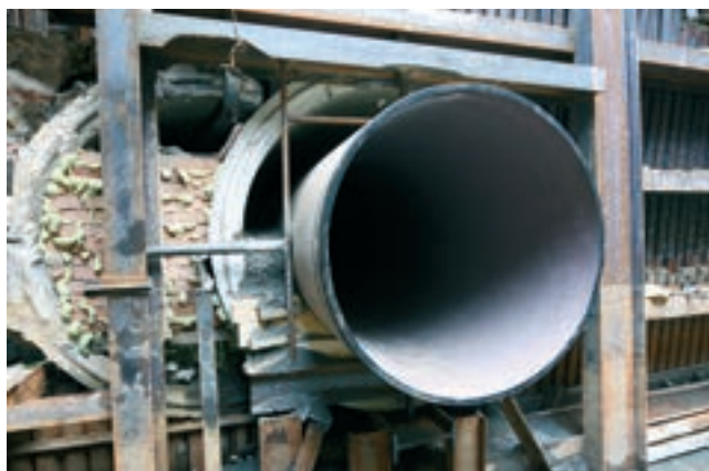
Obr. 15: Stará a nová, ale obě stejné štítované štoly
