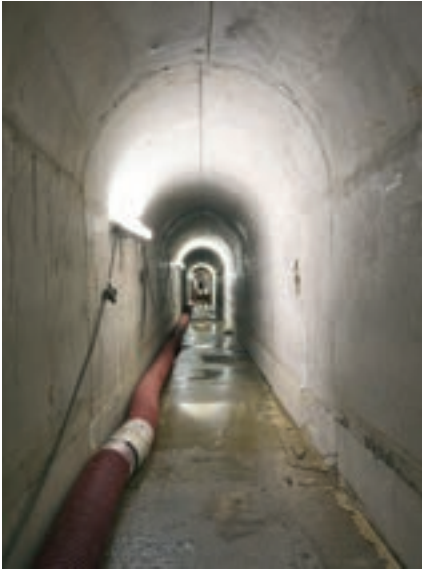
Obr. 4: Staňkova – monolitické ostění DN 1 000/1 600 mm před betonáží kynety z čediče a kompletně dokončená stoka v ulici Dvorského s čedičovým žlabem
