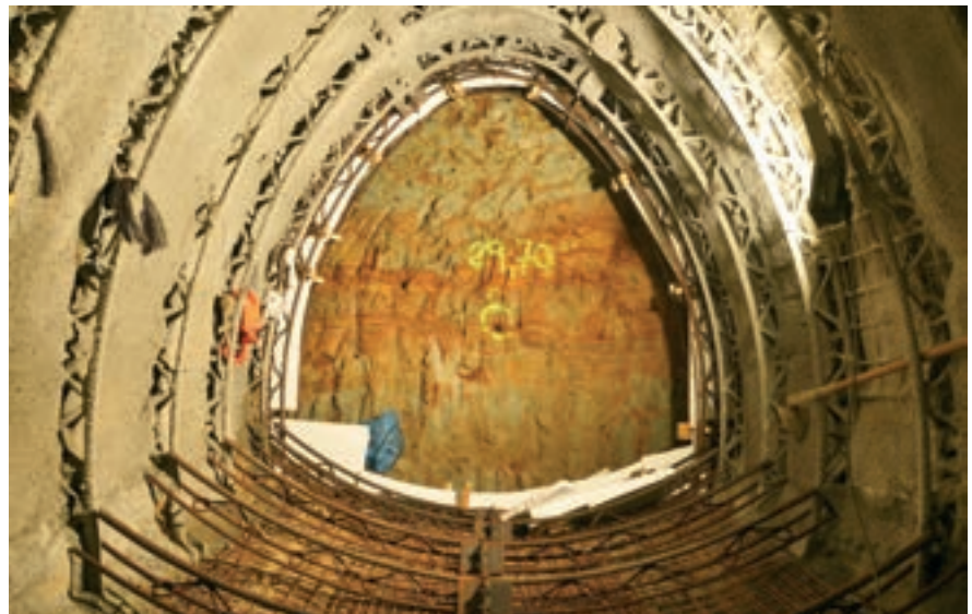
Obr. 7: Pohled na čelbu štoly s homogenním pískovcem. Příhradová výztuž s protiklenbou a ostěním ze stříkaného betonu
