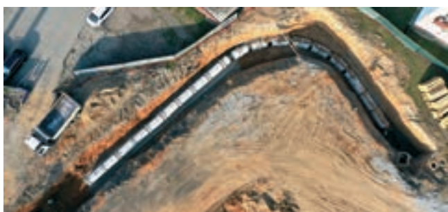
Obr. 6: Oblouk kanalizace z ptací perspektivy
