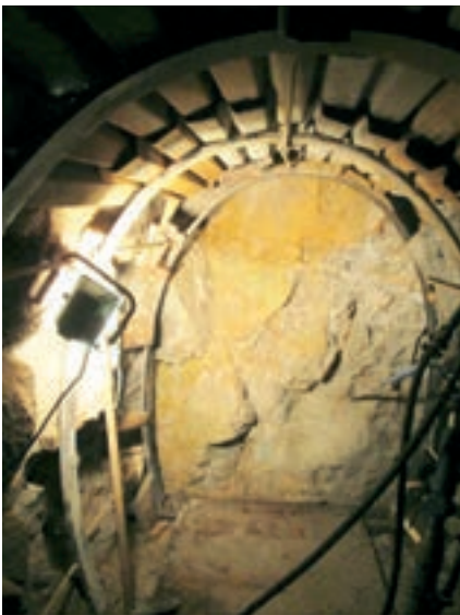
Obr. 6: Nejdek – rostlá zdravá žula na čelbě štoly (ostění z důlní pásové výztuže)
