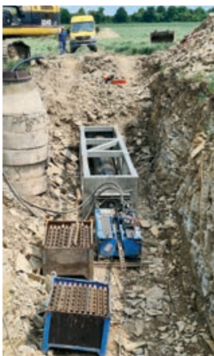
Hydraulické zařízení v cílové jámě
