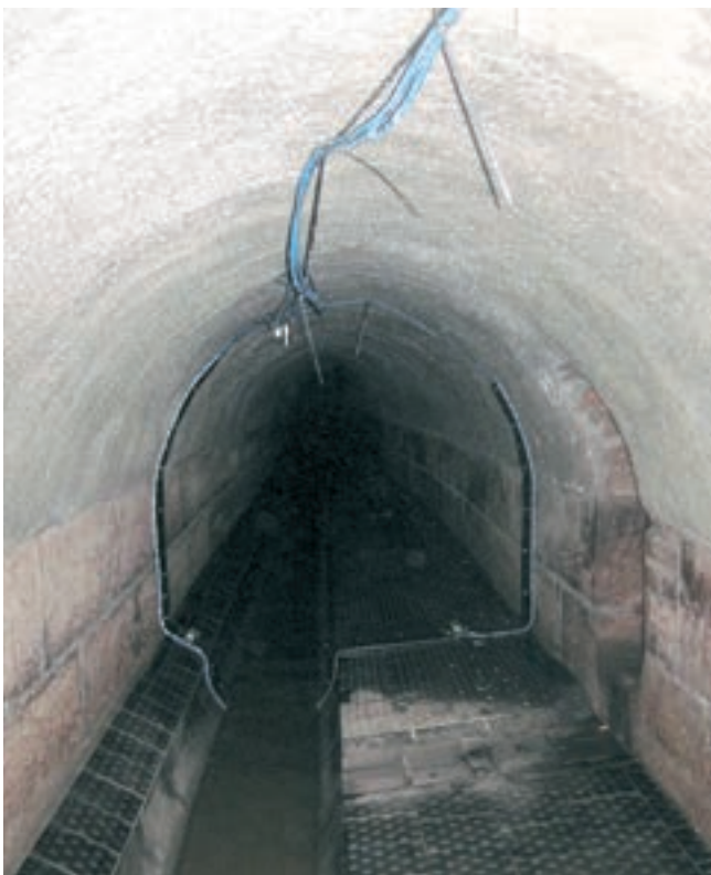
Osazení měřicí techniky v kanalizaci
