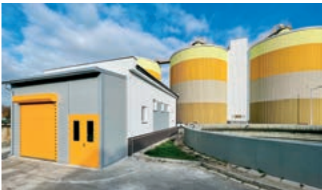
Obr. 1: Nový objekt strojního zahuštění kalu a vyhřívací nádrže
