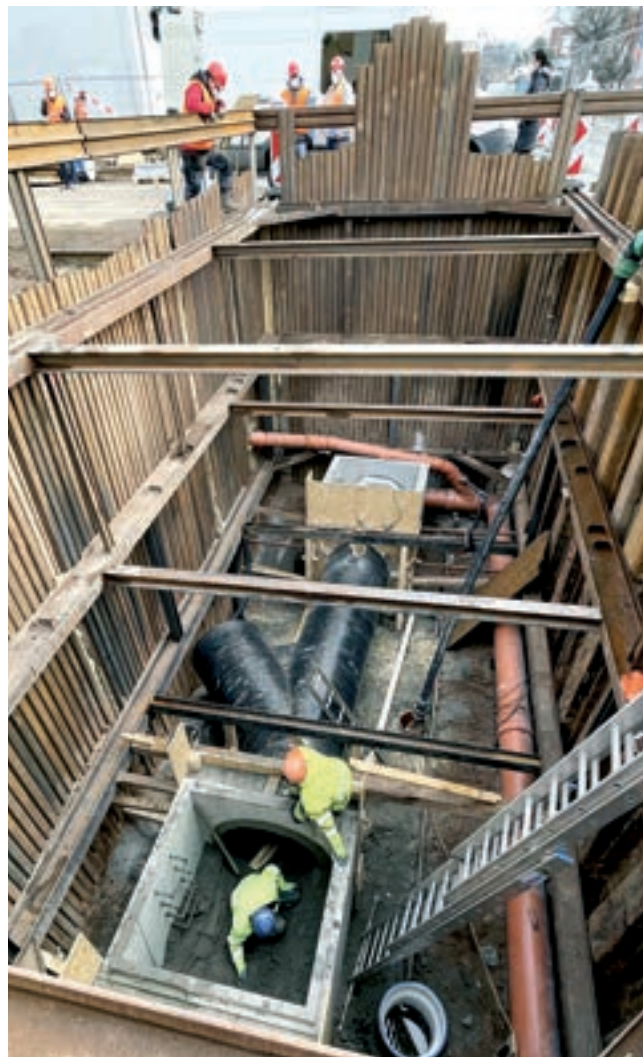
Rekonstrukce kanalizace v Hradci Králové, ulice Za Škodovkou
