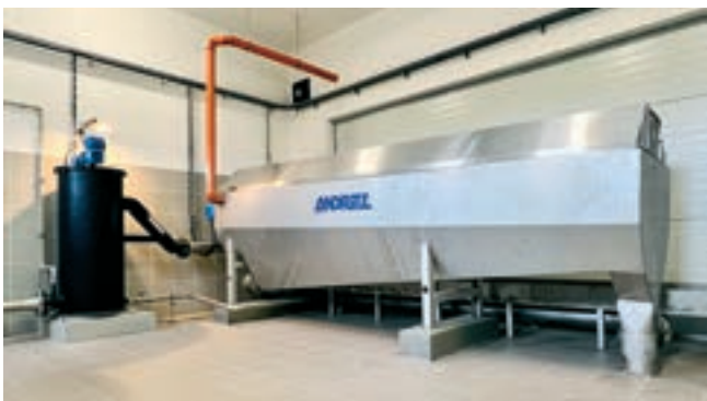
Obr. 2: Rotační zahušťovač přebytečného kalu
