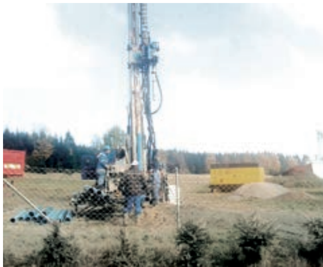
Obr. 2: Horní Světlá – vrtné práce
