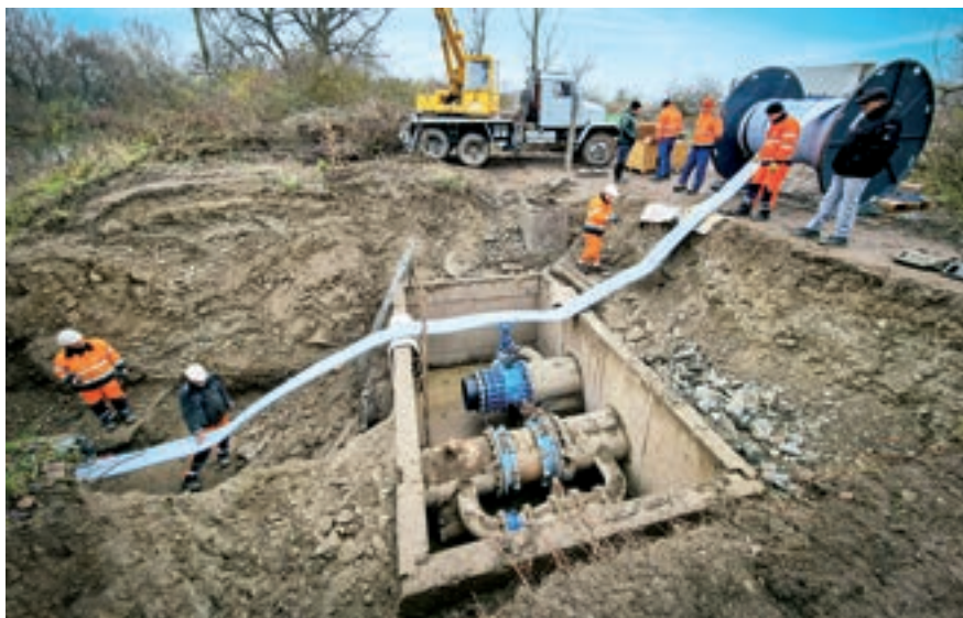
Zatahování vložky z transportní cívky
