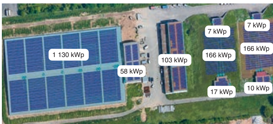
Obr. 5: Dispozice fotovoltaického systému. Čerpací stanice a vodojem v pražské aglomeraci s částí fotovoltaického systému určenou pro vlastní spotřebu a částí pro dodávky do distribuční sítě.
